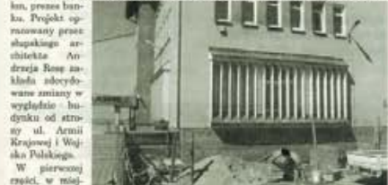
Rozkopano w ul. Wójcika Polskiego to zwalisko gruntu przy dobudowaniu Banku Spółdzielczego.
