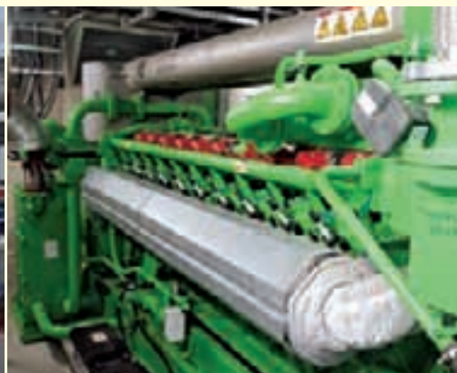
Jeden z trzech silników układu kogeneracyjnego przy ul. Lidzbarskiej 33
