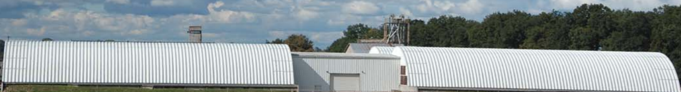
Nowoczesna przechowalnia ziemniaków w Cepnie
