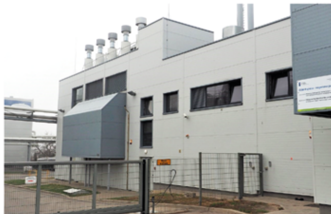
Kogeneracja Caterpillar. Zainstalowane OSM Piątnica agregaty gazowe marki CAT® 2xC3512E oraz G3516H.
