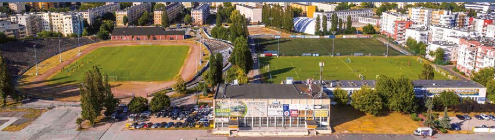
Kompleks sportowy Chemik przy ul. Glinki
