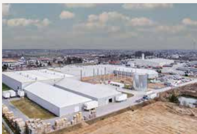
Rozbudowa Fabryki Fey, Topole (obok Chojnic). Rok 2024.
